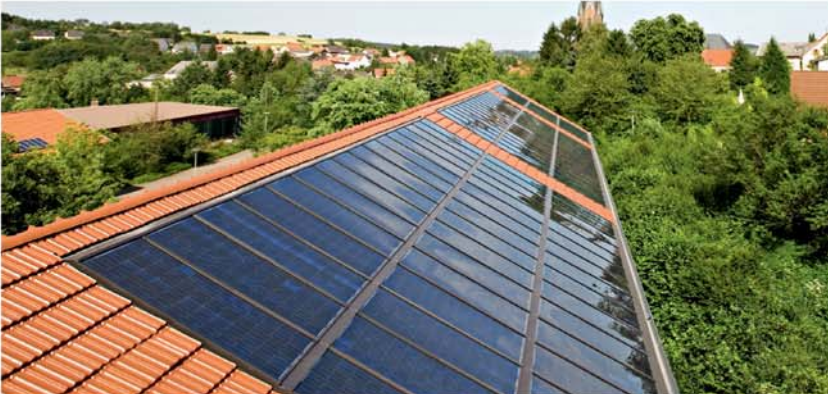
Okul binası (Uchtelfangen/Almanya) : 30kW fotovoltaik sistem)
