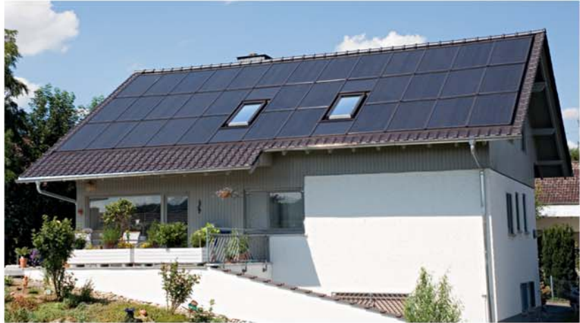
Müstakil ev, Hünstetten / Almanya. 9,45kW fotovoltaik sistem ve 2 Roto çatı penceresi)
